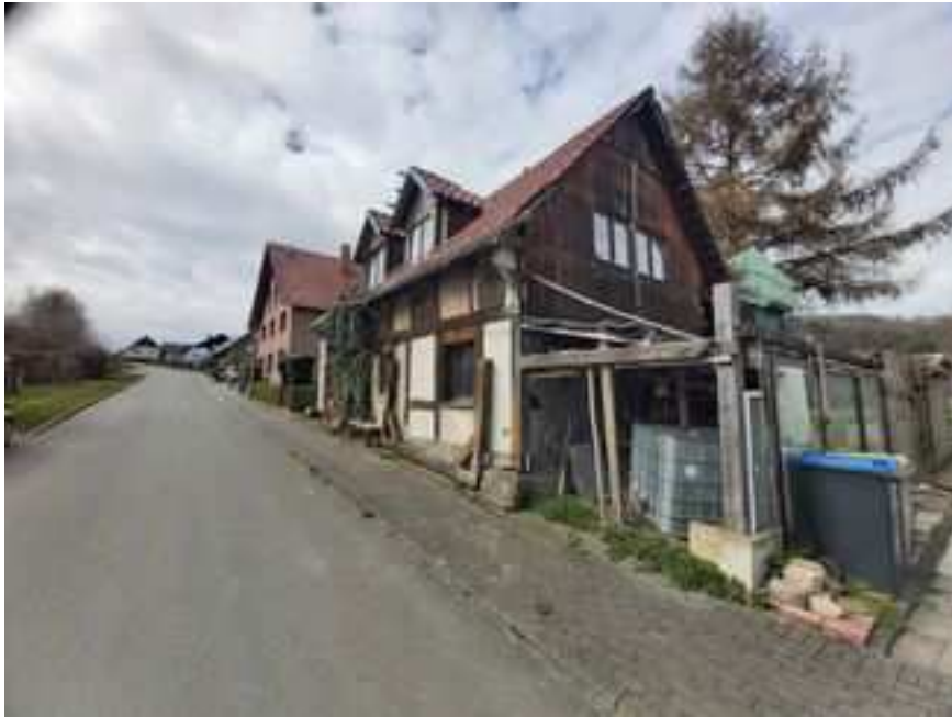
östliche Giebelansicht mit dem provisorischen Unterstellplatz
