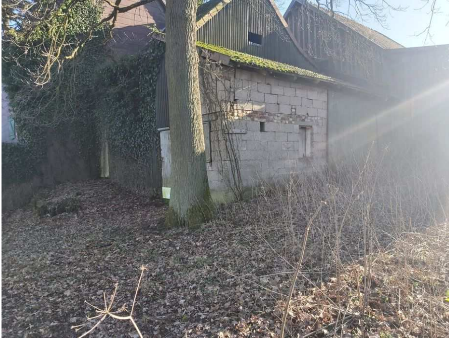
Nordwestansicht des rückwärtigen Anbaus
