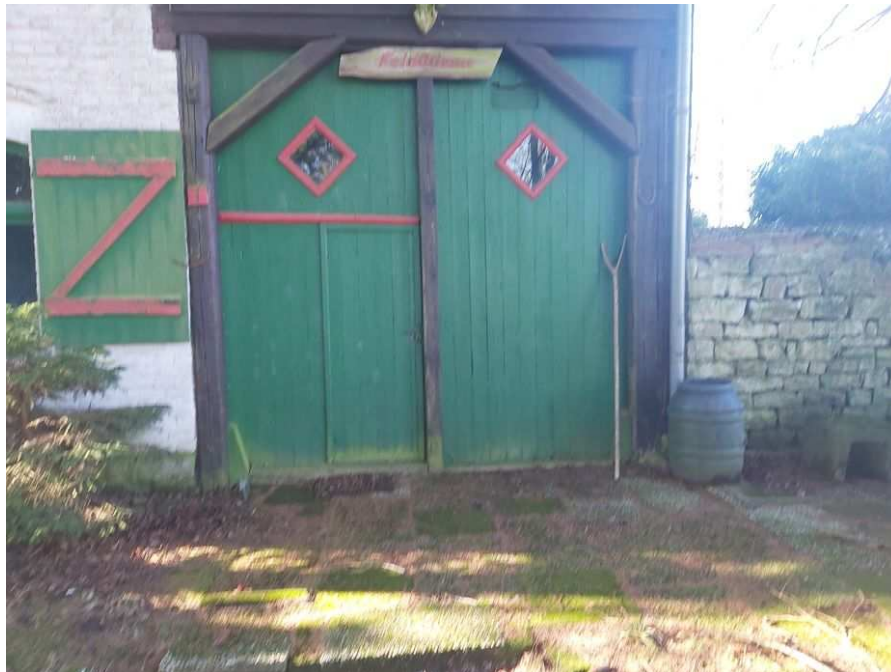
Dielentor mit einer einflügeligen Schlupftür als Haupteingang
