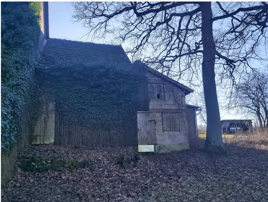
Nordostansicht des ehemaligen Stalls als Anbau
