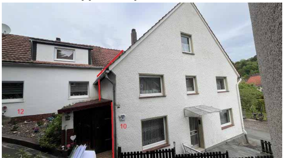
Ansicht von Süden, rechts Bewertungsgrundstück Ringstraße 10, links Haus-Nr. 12
