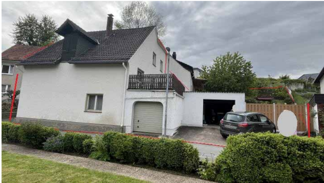
Ansicht von Osten, ungefähre Grenzverlauf des Grundstücks rot einskizziert
