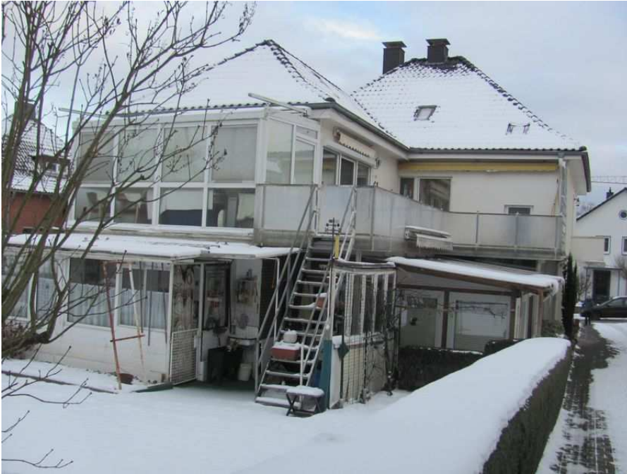
rückwärtige Westansicht mit den Einhausungen im Erdgeschoß, dem Wintergarten und dem Balkon
