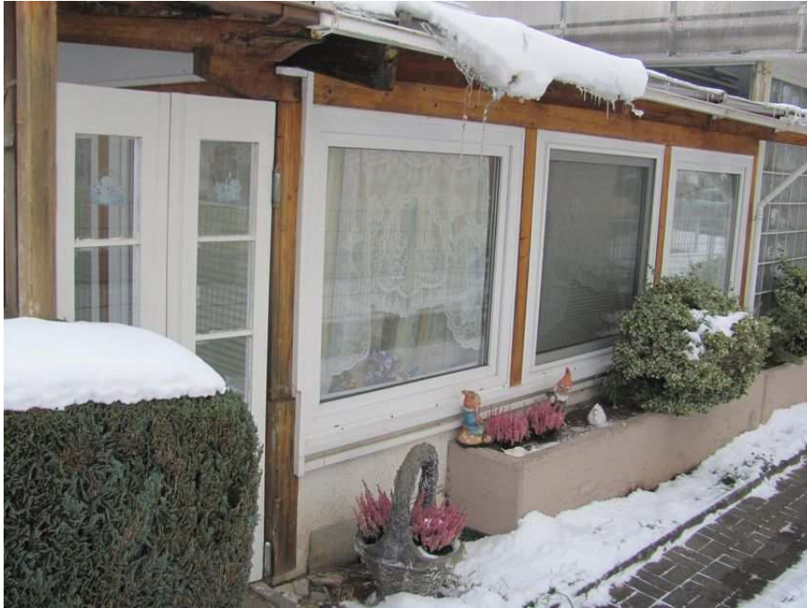
Einhausung an der Südgrenze als einfache Holzkonstruktion
