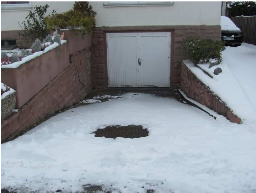
Zufahrt zur Garage im Kellergeschoß
