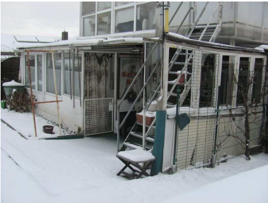
gartenseitige Einhausung als einfache Holzkonstruktion
