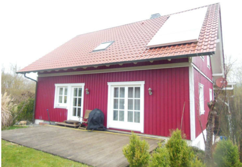
Südansicht mit der Terrasse und dem Solarfeld auf dem Dach
