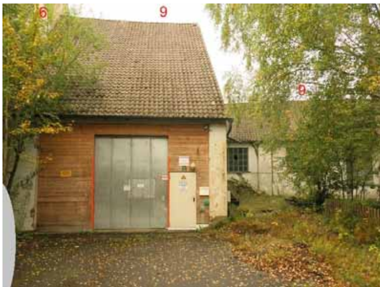
Ansicht von Norden
