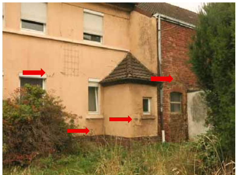
Beispiel A) Fassadenanstrich vermutlich dampfdiffusionsdicht, verhindert Feuchtetransport; Außenwand Stallung B) rechts, mit stärkeren Setzrissen
