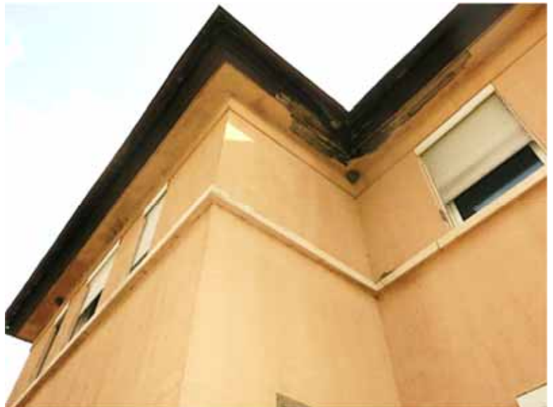
Beispiel A) Fassadenanstrich vermutlich dampfdiffusionsdicht, verhindert Feuchtetransport; Außenwand Stallung B) rechts, mit stärkeren Setzrissen
