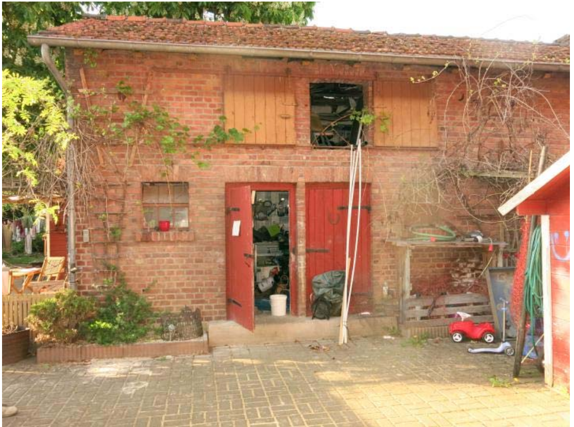
Höxtersche Straße 23, „Hinterhof“; Blick zum Nebengebäude
