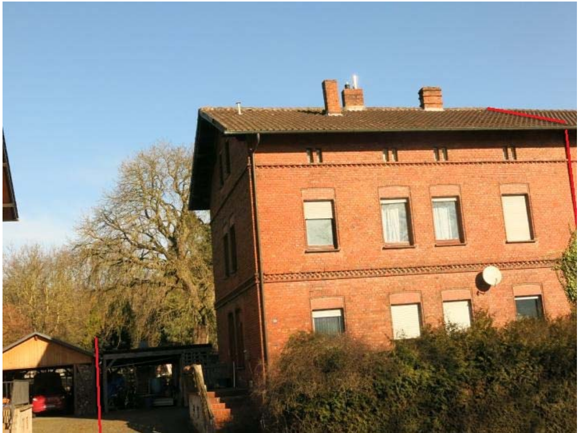
Höxtersche Straße 23, Ansicht von Süden
