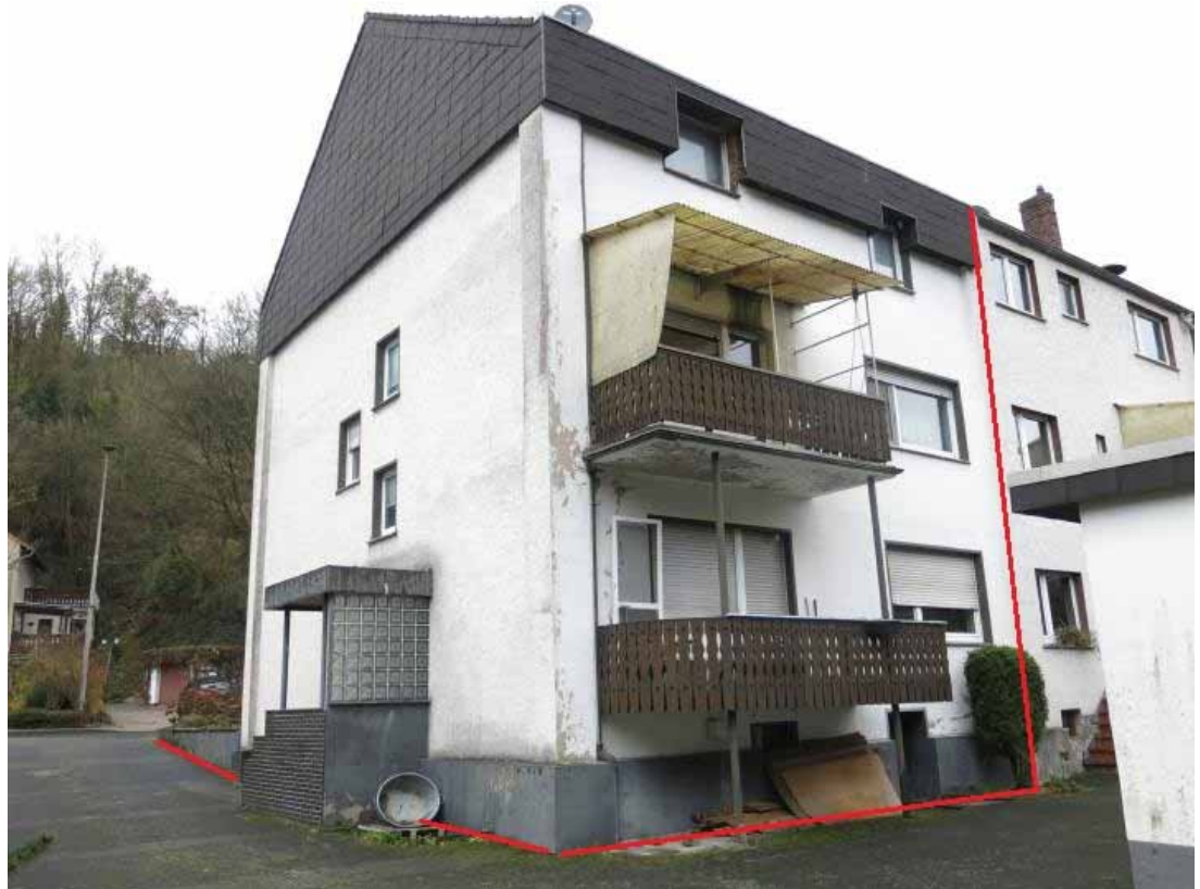
Obere Hauptstraße 217 - 219, Ansicht von Süd-Westen;
