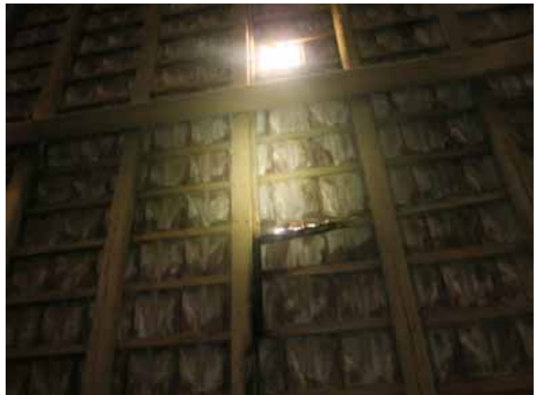
Beispiel Stallung B) Dacheindeckung überaltert/ tlw. schadhaft → Lattung mittig bereits morsch
