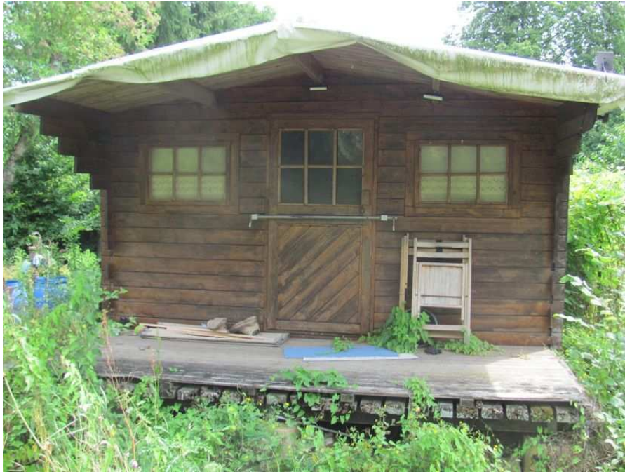
Gartenlaube mit schadhafter Veranda und Dachabdeckung mit einer Plane
