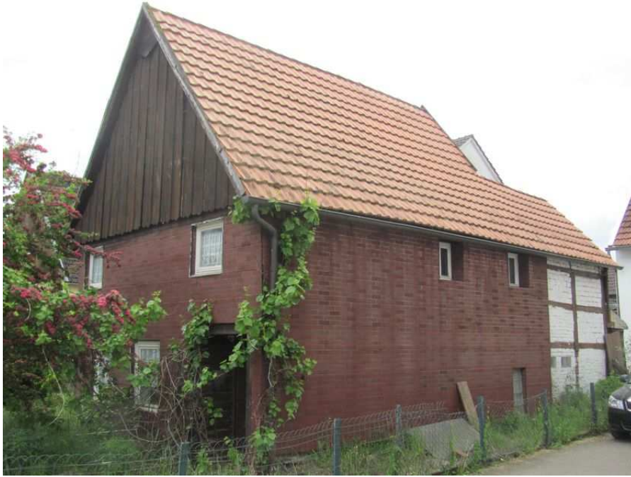
straßenseitige Giebelansicht mit der Haustür und nördliche Traufwand
