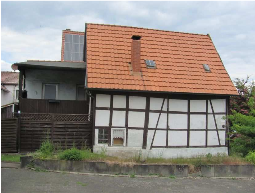
südliche Traufwand mit der überdachten Loggia im Obergeschoß
