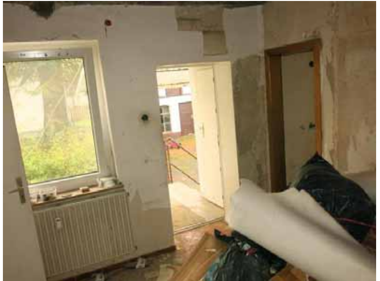
Beispiel A) EG, „Diele“: Zugang über Nebeneingang; begonnene Ausbaurbeiten
