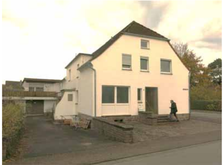
lfd. Nr. 13; Blick von Osten; Wohnhaus A) hinten links Doppelgarage C)
