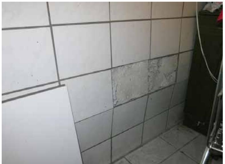
Beispiel Garage: Feuchteschäden an Außenwand
