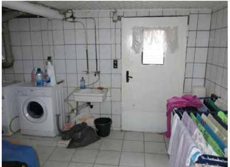
Beispiel Keller: Feuchteschäden ,it losen Fliesen an Außenwänden
