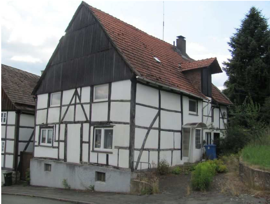
straßenseitiger Ostgiebel mit traufseitigem Hauszugang und Zufahrt
