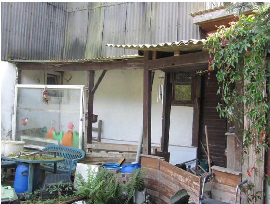
rückwärtige Nebengebäude mit überdachtem Lager
