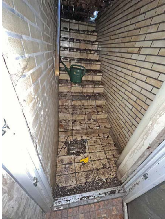
Kelleraußentreppe, mit Terrassenbelag abgedeckt
