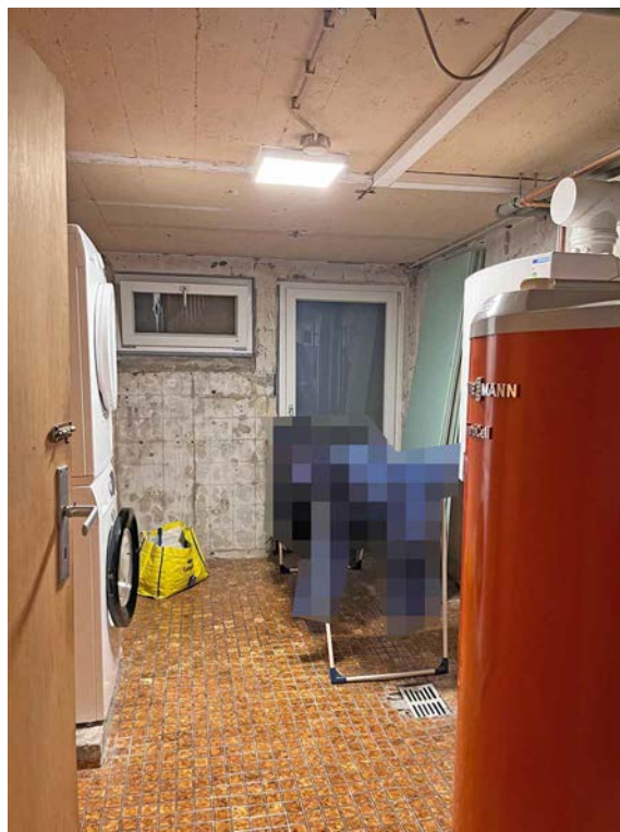
Wasch- und Heizkeller hinten rechts mit Ausgang zur Kelleraußentreppe
