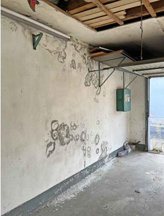
Außenwand Garage mit Feuchtigkeitsschäden
