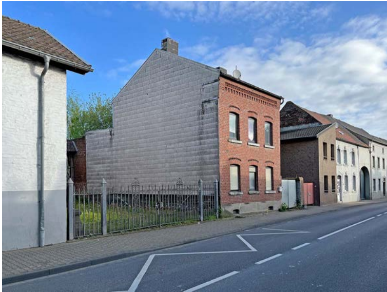
Neusener Straße 57, Ansicht von Süden
