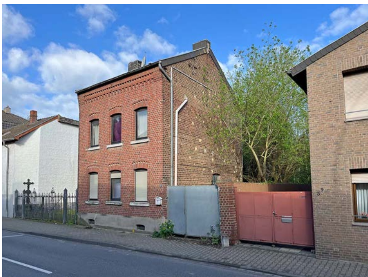
Ansicht von Osten
