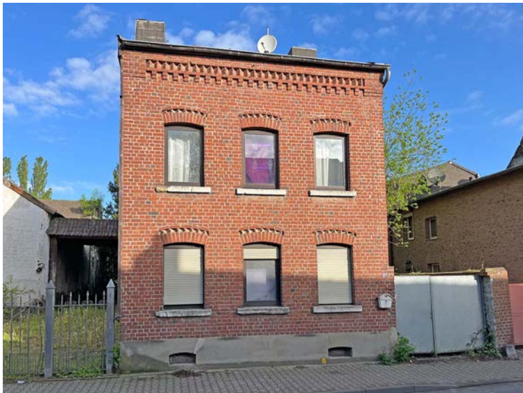
Neusener Straße 57, Ansicht von Südosten
