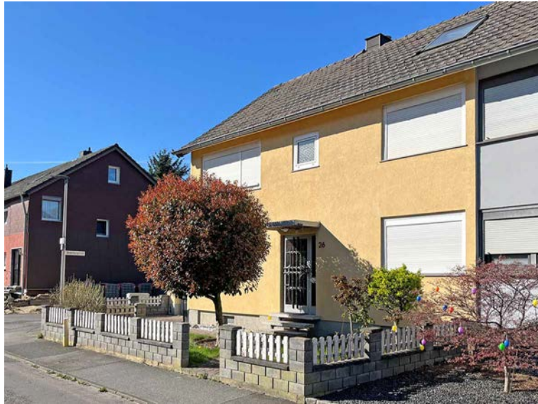
Lörschpülgen 26, Ansicht von Nordosten
