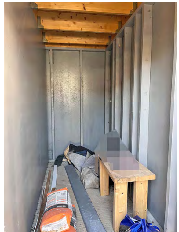
Abstellraum innen, exemplarisch
