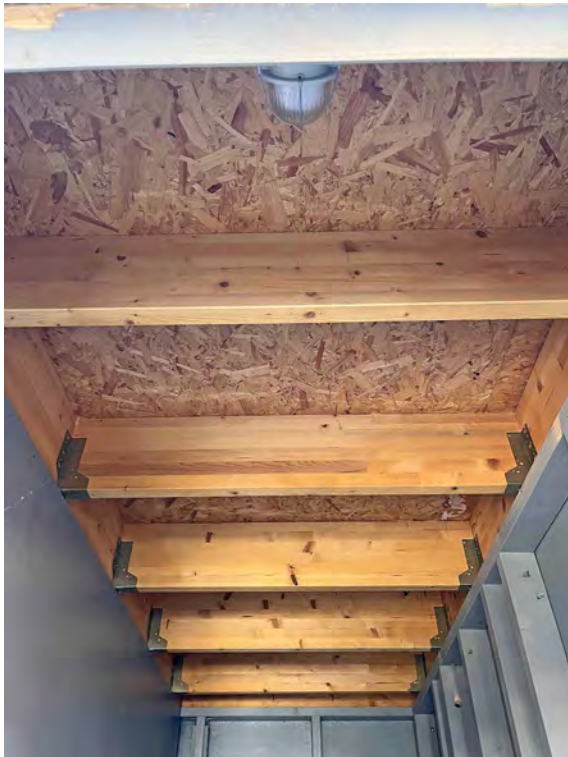
Decke Abstellraum (exemplarisch)
