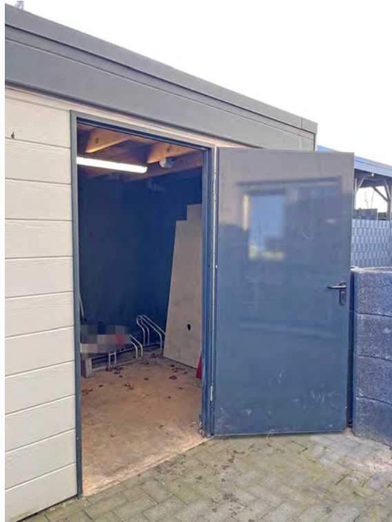
Zugang hinterer Fahrradschuppen
