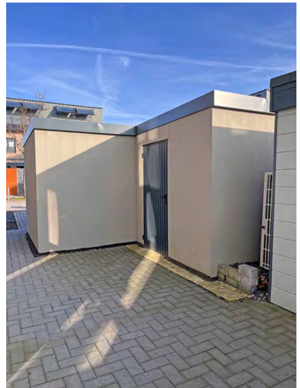
Hausanschlussraum und Fahrradschuppen
