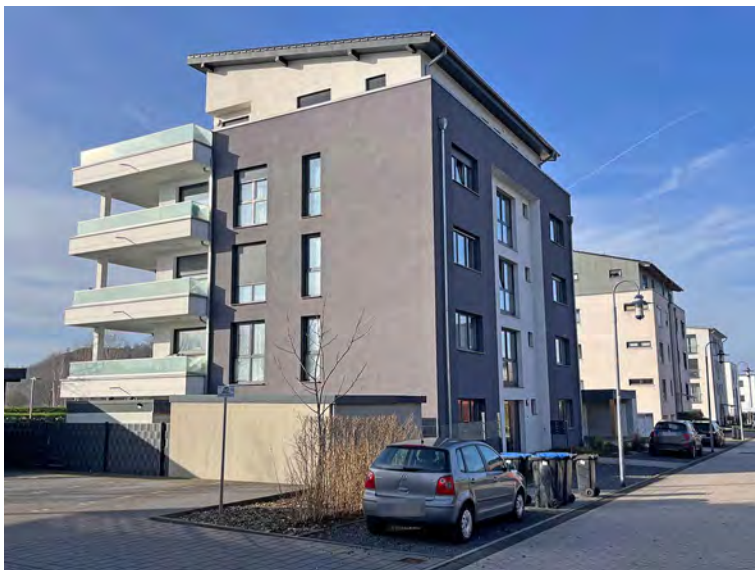
Ansicht von Nordwesten mit Hausanschlussraum
