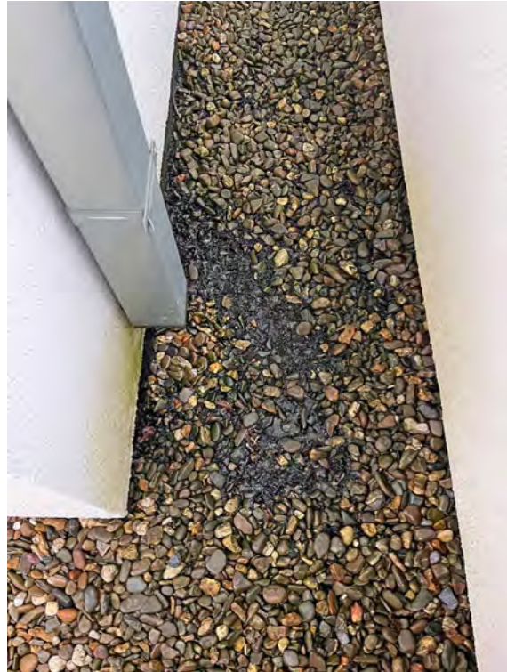
freie Entwässerung des Pultdachs auf die Dachterrasse
