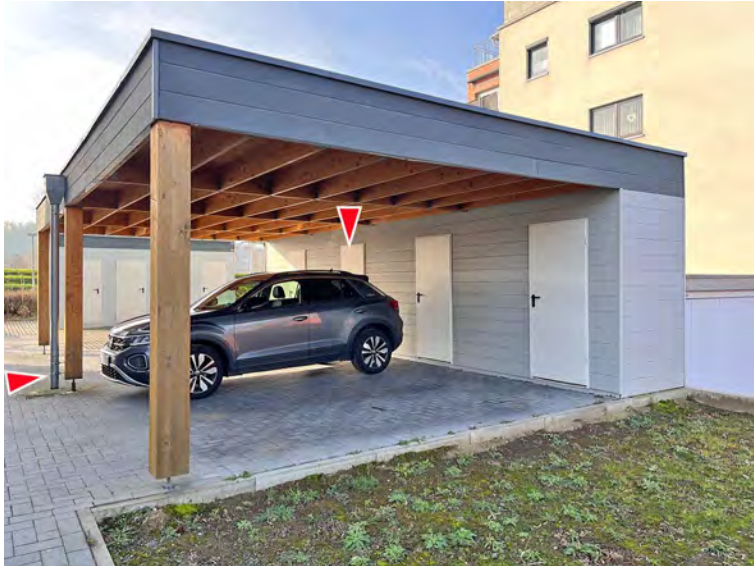
Carport mit Stellplatz P7 und Abstellraum 7-W zu ATP-Nr. 7
