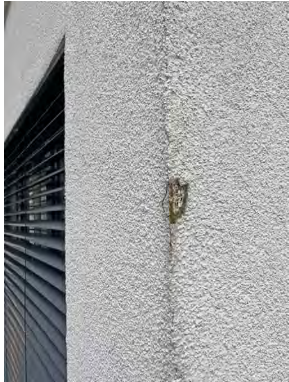
Putzbeschädigung
