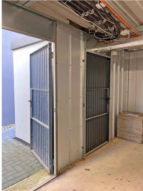
vorderer Fahrradschuppen mit Zugang zum Hausanschlussraum
