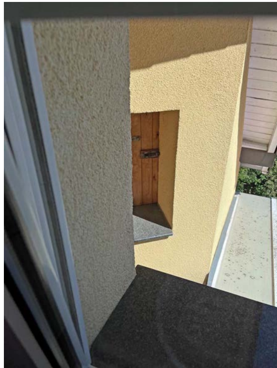
Zugang zum Speicherraum über dem Bad
