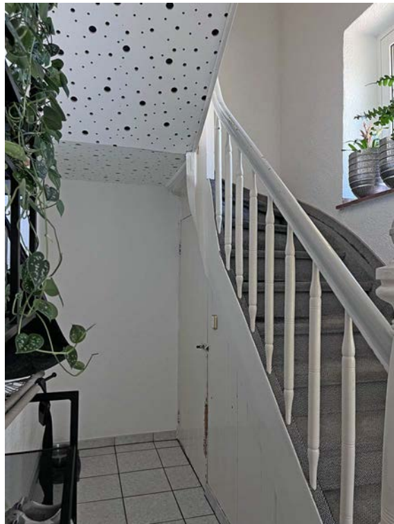
Flur mit Zugang zur Kellertreppe
