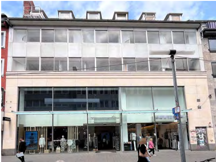
Adalbertstraße 25/25a, Ansicht von Süden
