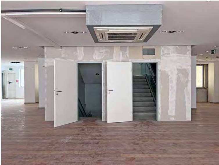
2. OG mit abgekofferter Freitreppe
