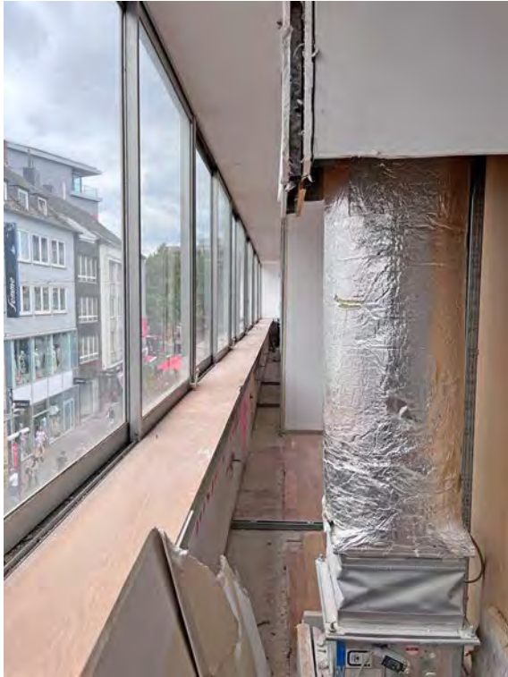
Fassade Adalbertstraße mit einfachverglasten Aluminiumfenstern
