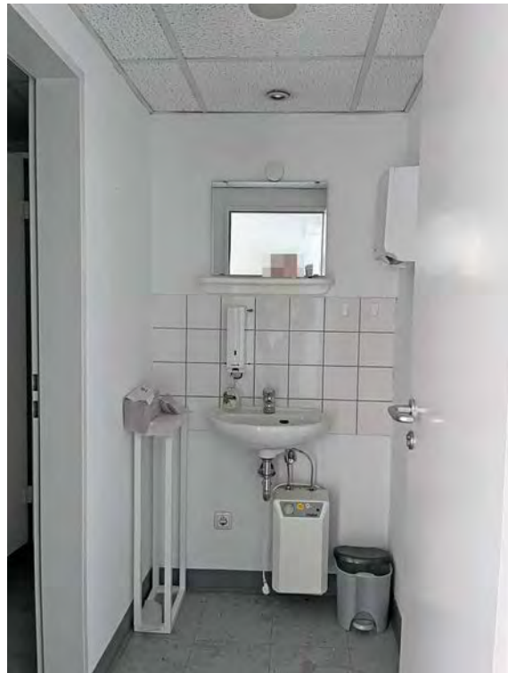
Vorraum WC DG (beispielhaft)
