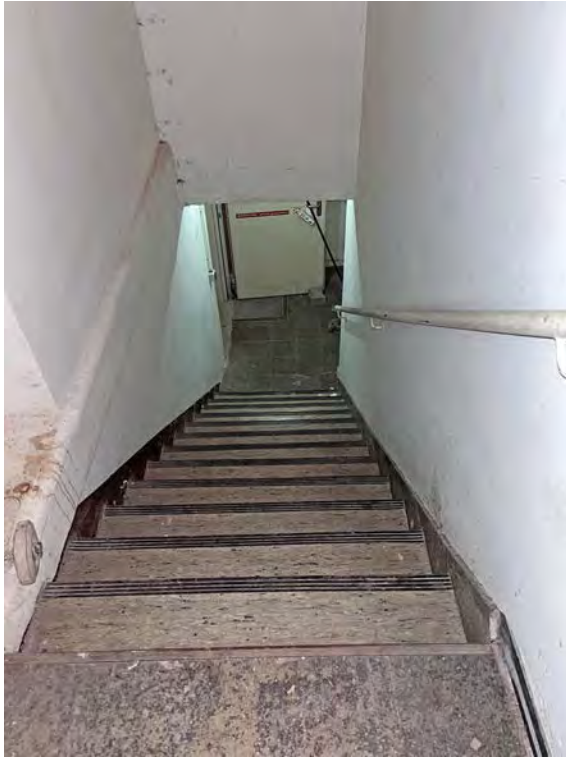
Treppe ins Kellergeschoss
