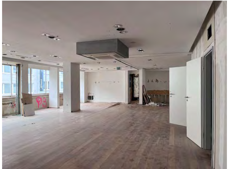
2. OG mit abgetrennter Freitreppe in Richtung Westen
