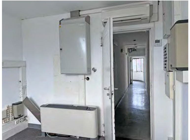
Büroraum DG vorne links, Flur
