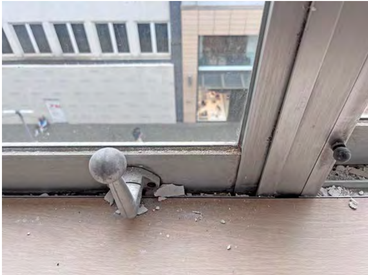
Aluminiumfenster mit Einfachverglasung in Richtung Adalbertstraße im 3. OG
