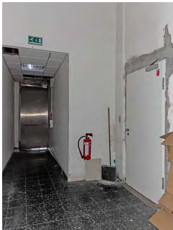
Eingangsflur Treppenhaus mit Seiteneingang Laden rechts
