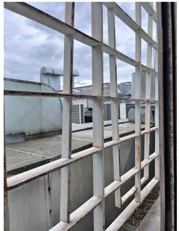
Vergitterung der Fenster zum Flachdach hinten
