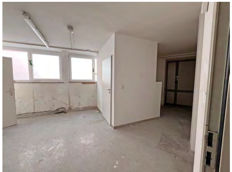
Personalraum (noch nicht fertiggestellt), OG Blondelstraße
