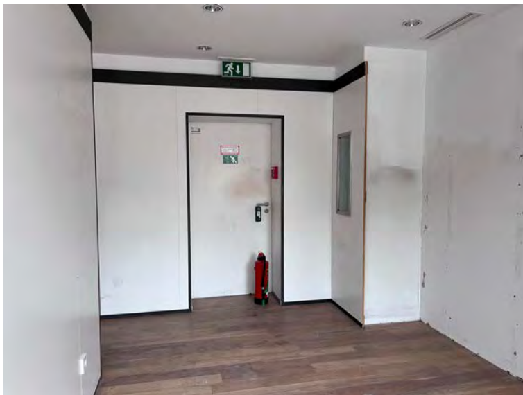
Zugang zum Treppenhaus im 3. OG
