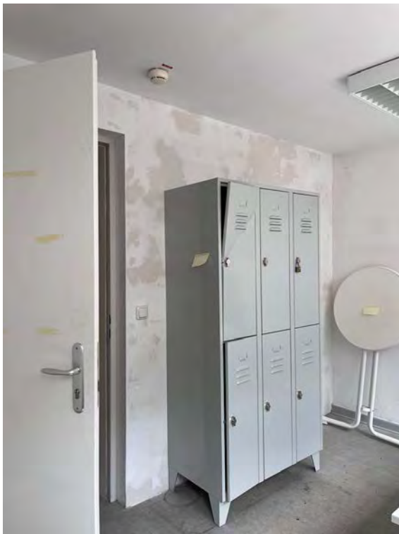
Büro o. ä., OG Blondelstraße
