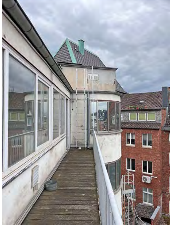
Balkon in Richtung Westen mit Aufzugsturm
