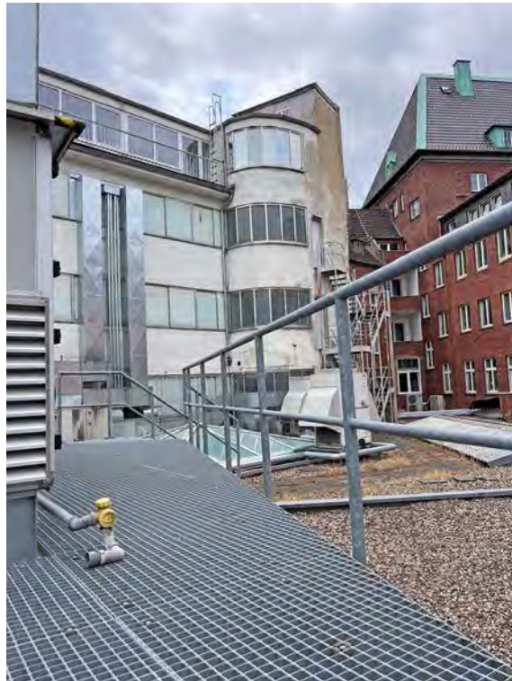
Teilansicht Adalbertstraße von Norden mit Aufzugsturm und Fluchttreppe
