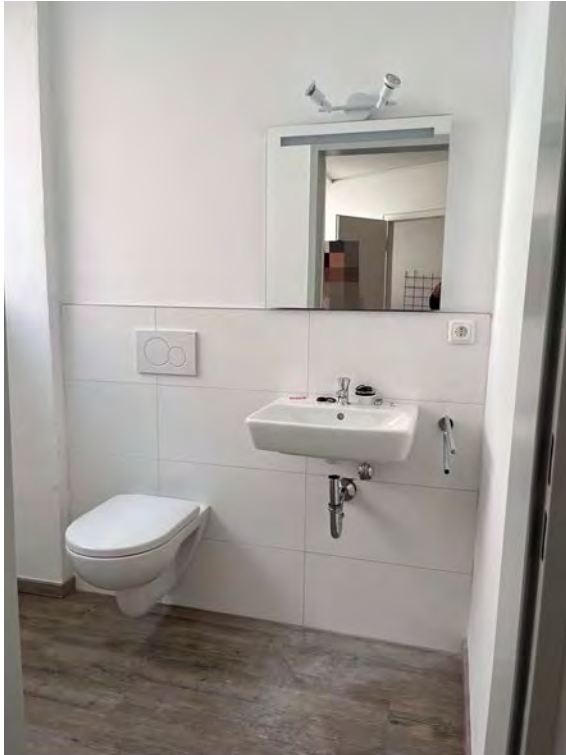
WC OG Blondelstraße (noch nicht fertiggestellt)
