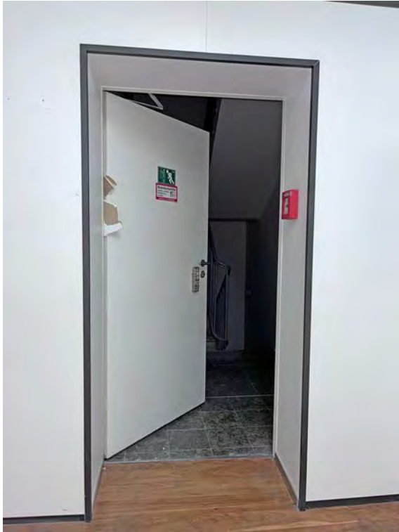
Zugang vom 1. OG zum Treppenhaus
