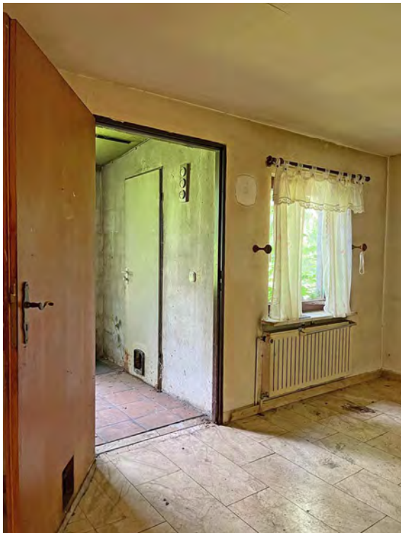
Zugang zum Heizungsraum
