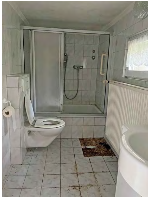
Bad I im Kellergeschoss
