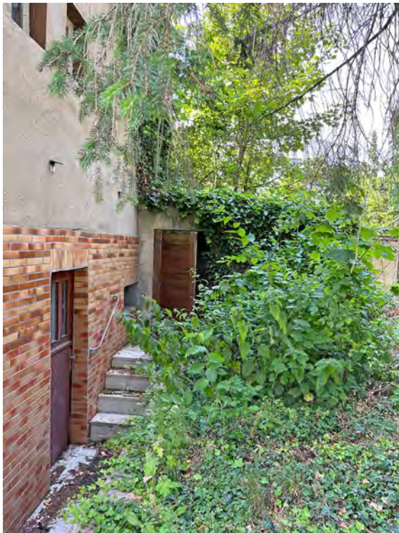
Drosselweg 27, Kelleraußentreppe, Anbau
