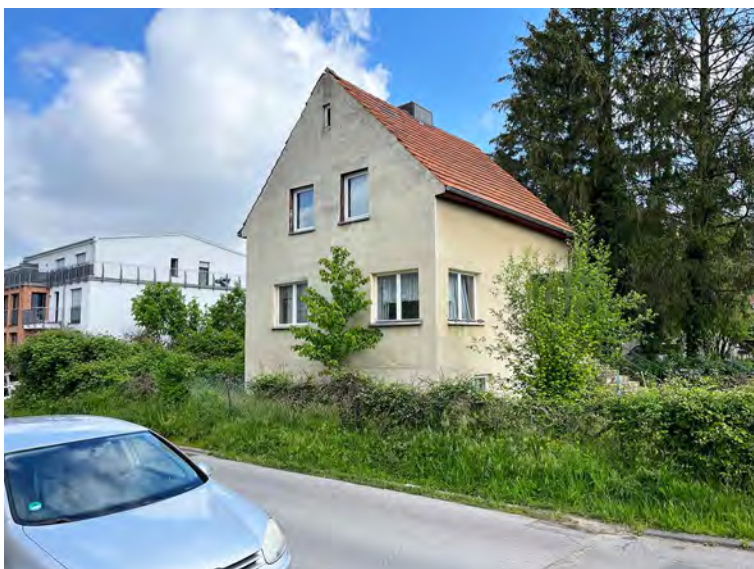
Drosselweg 27, Ansicht von Süden
