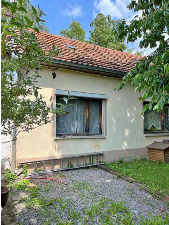
Halle hinten (Lpl. Nr. 3) (zu Wohnzwecken genutzt)
