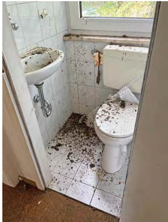
WC im DG
