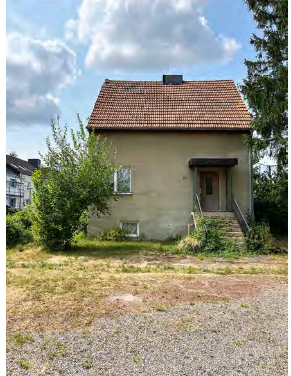
Drosselweg 27 (Lpl. Nr. 1), Ansicht von S-O
