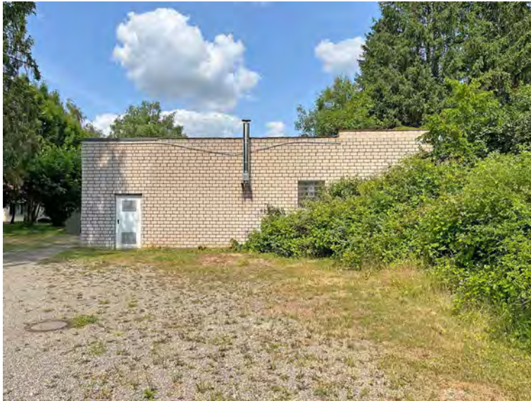
Halle rechts (Lpl. Nr. 2), Ansicht von Südwesten
