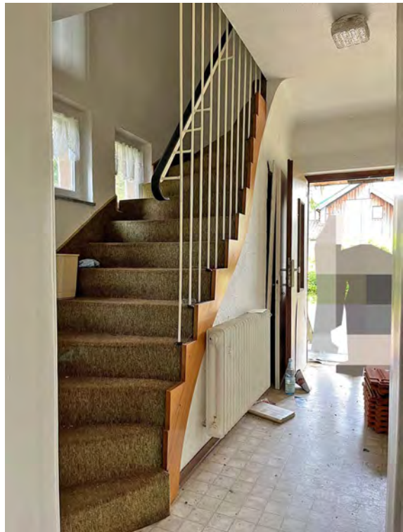
Treppe ins Dachgeschoss
