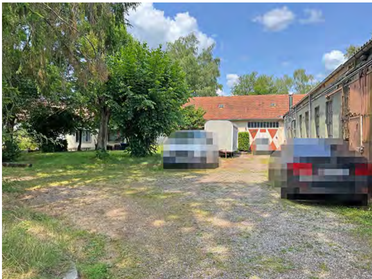
Halle rechts und Halle hinten, Hofffläche
