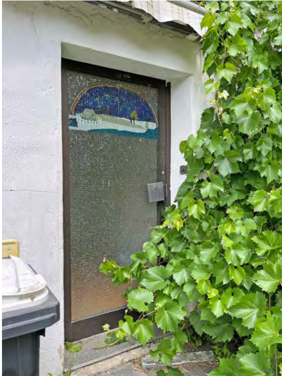
Eingang Wohnhaus hinten links
