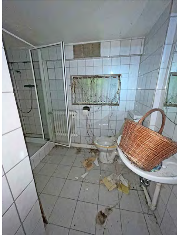
Bad II im Kellergeschoss
