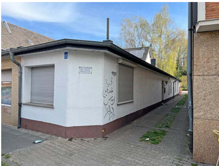
Am Bach 10 mit Zuwegung auf Flurstück 623, Ansicht von Südwesten
