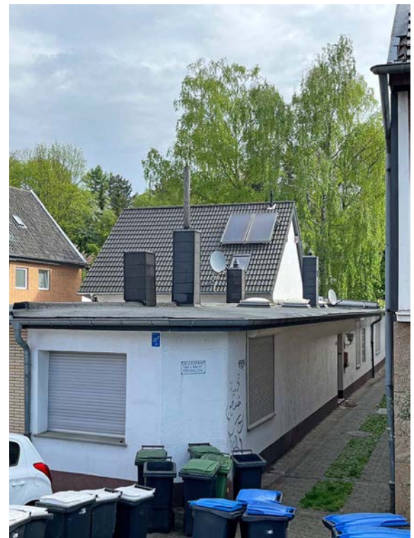
Am Bach 10 mit Dachaufsicht
