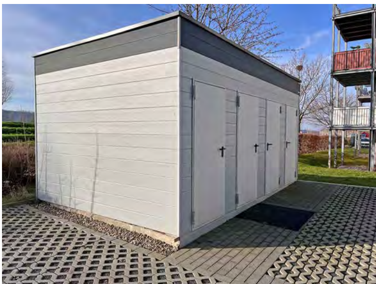
Abstellräume zu ATP-Nr. W1, W3, W4 und W6
