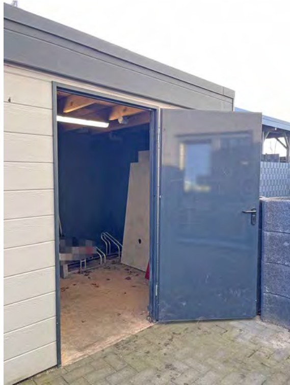
Zugang hinterer Fahrradschuppen
