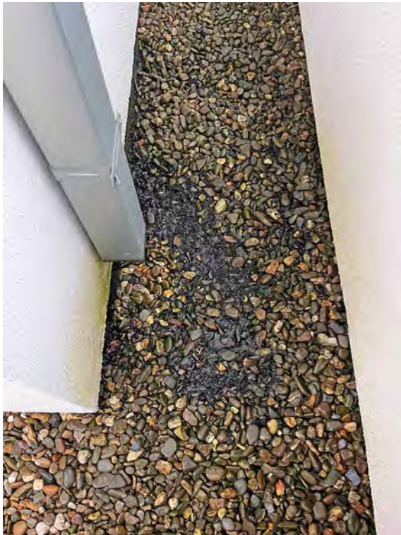
freie Entwässerung des Pultdachs auf die Dachterrasse
