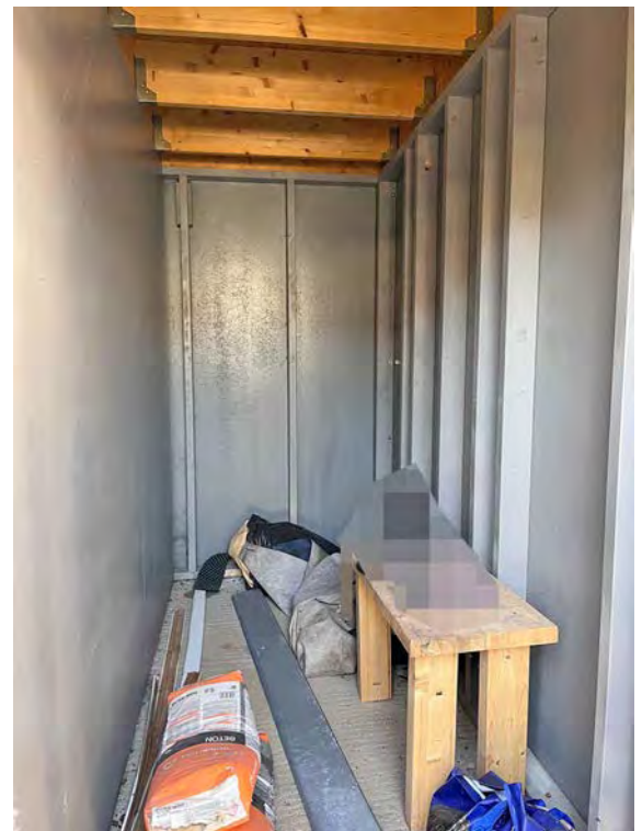
Abstellraum innen, exemplarisch
