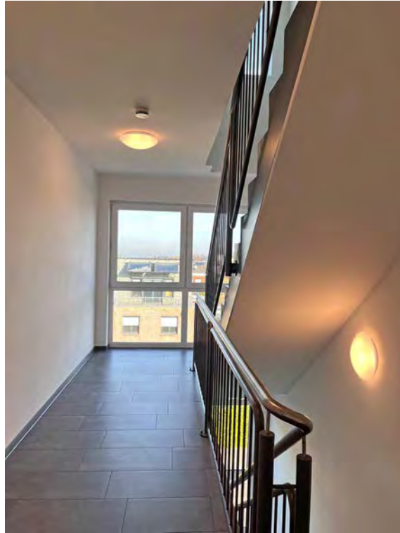
Treppenhaus in Richtung Straße (exemplarisch)
