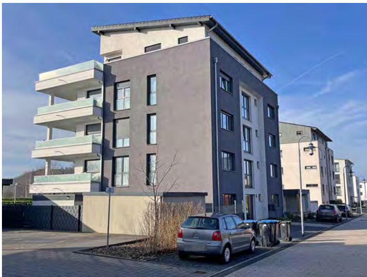
Ansicht von Nordosten mit Hausanschlussraum
