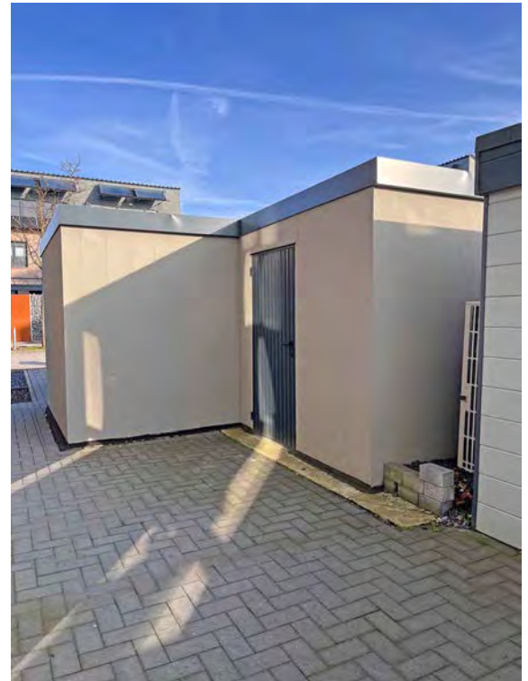
Hausanschlussraum und Fahrradschuppen
