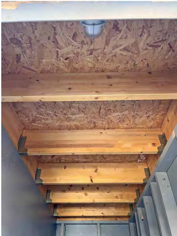
Decke Abstellraum (exemplarisch)
