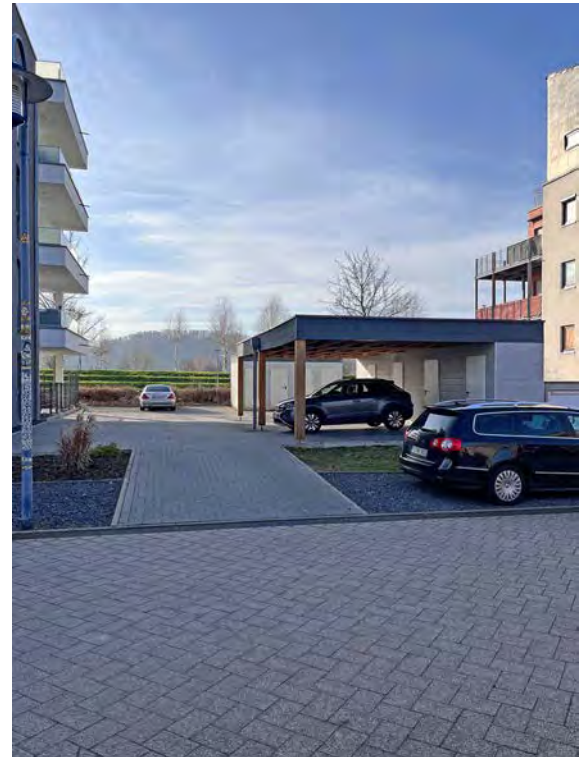
Zufahrt zu den Stellplätzen, Carports und Abstellräumen
