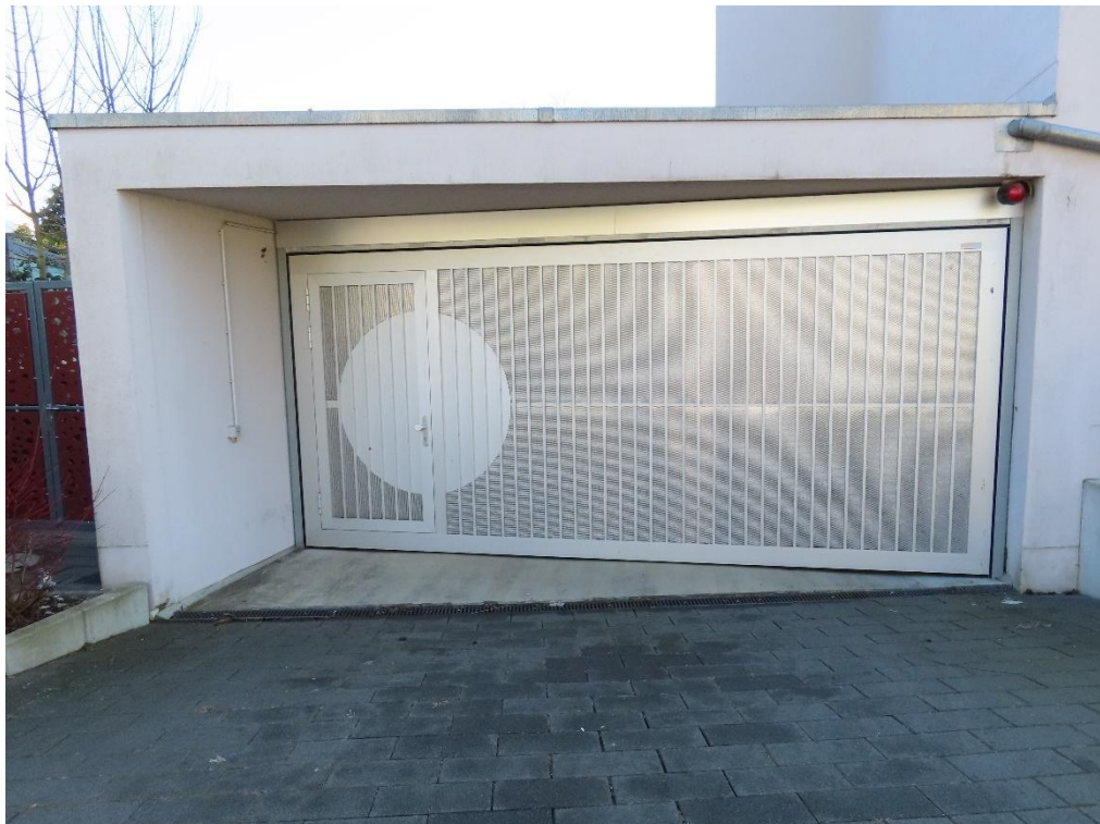
Abb. 7 + 8: Zufahrt zur Tiefgarage
