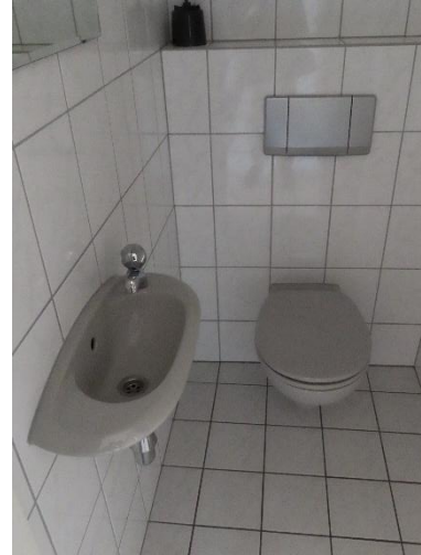
Gas-Zentralheizung Heizkörper mit Thermostat-Ventilen Heizung in den Bädern weitgehend als Handtuch- Wärmekörper Heizzentrale als Brennwerttherme aus 2006
