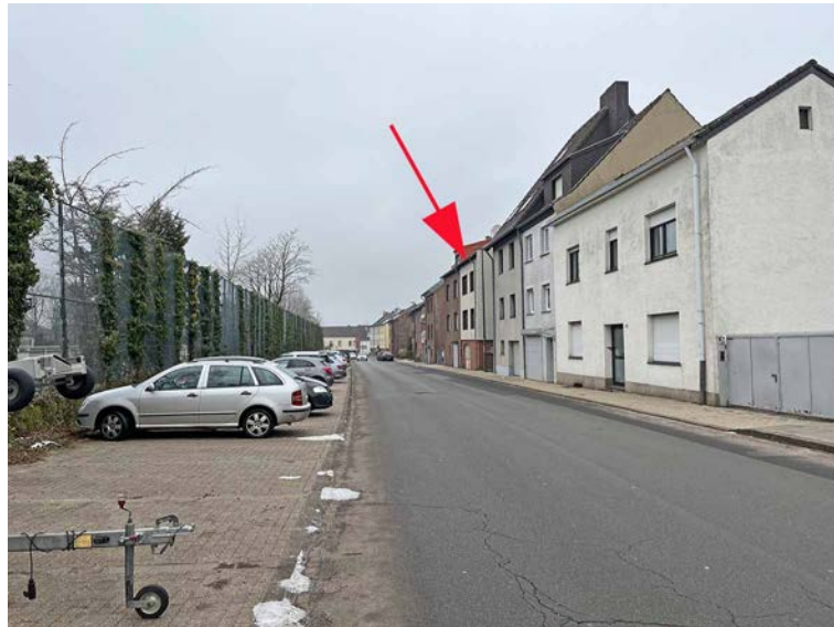
Brander Straße in Richtung Nordwesten
