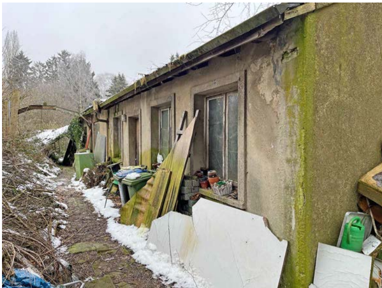
Schuppengebäude. Ansicht von Westen
