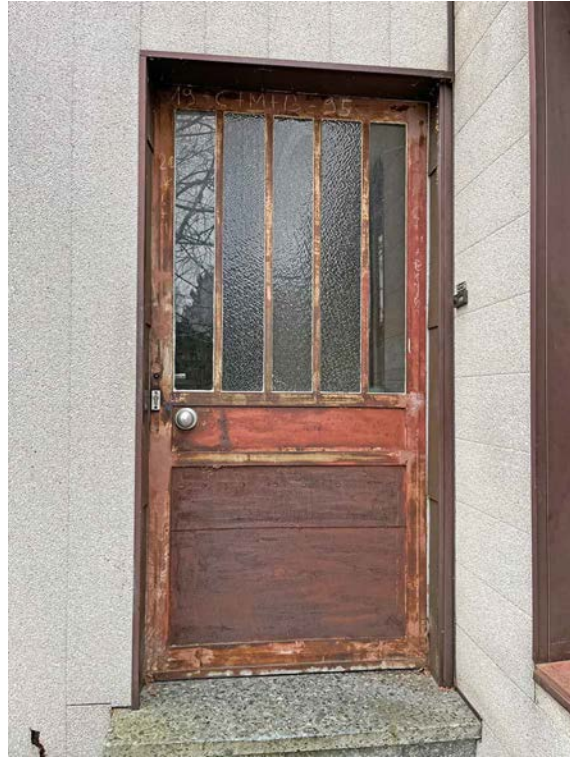
Hauseingangstür auf der Gebäuderückseite
