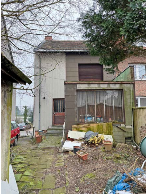
Ansicht von Nordosten mit Anbau
