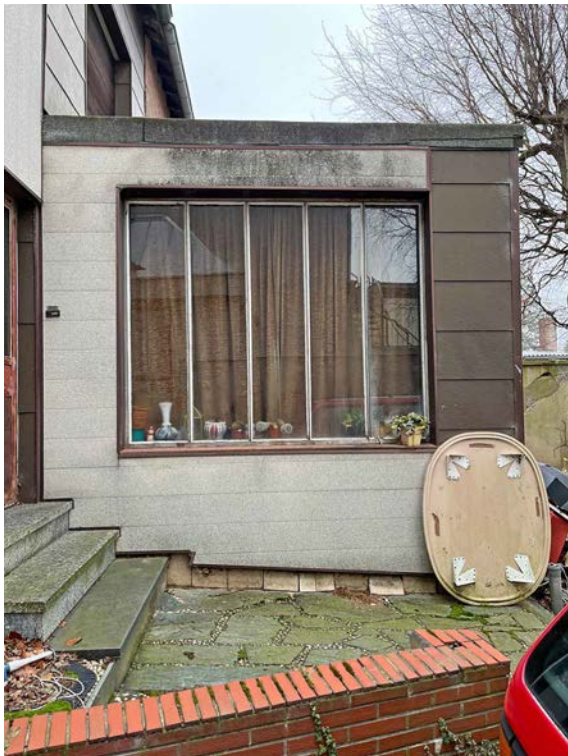
Anbau, Ansicht von Südosten
