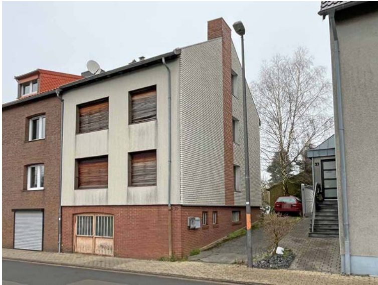
Brander Straße 35, Ansicht von Süden
