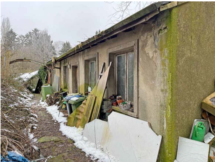
Schuppengebäude. Ansicht von Westen
