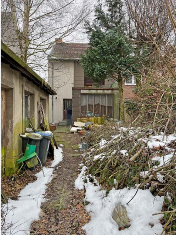
Rückansicht mit Schuppengebäude
