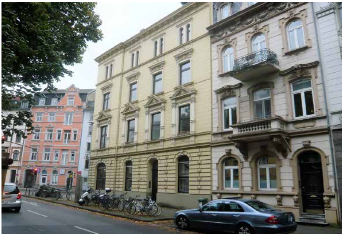
Strassenansicht Oppenhoffallee 138, ATP Nr. 2 im 1. OG links
