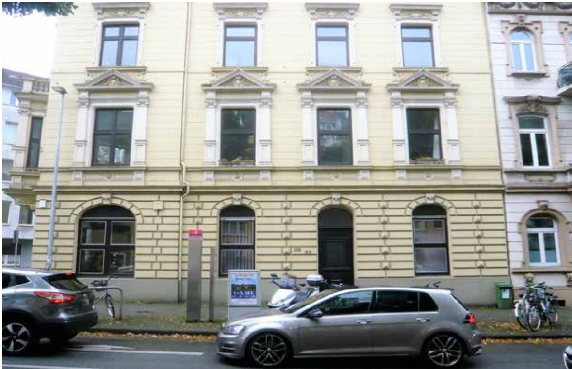
Teil-Strassenansicht Oppenhoffallee 138, ATP Nr. 2 im 1. OG links
