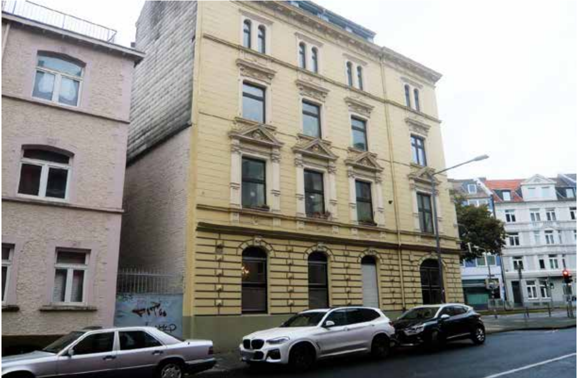
Strassenansicht Bismarckstrasse, ATP Nr. 2 im 1. OG
