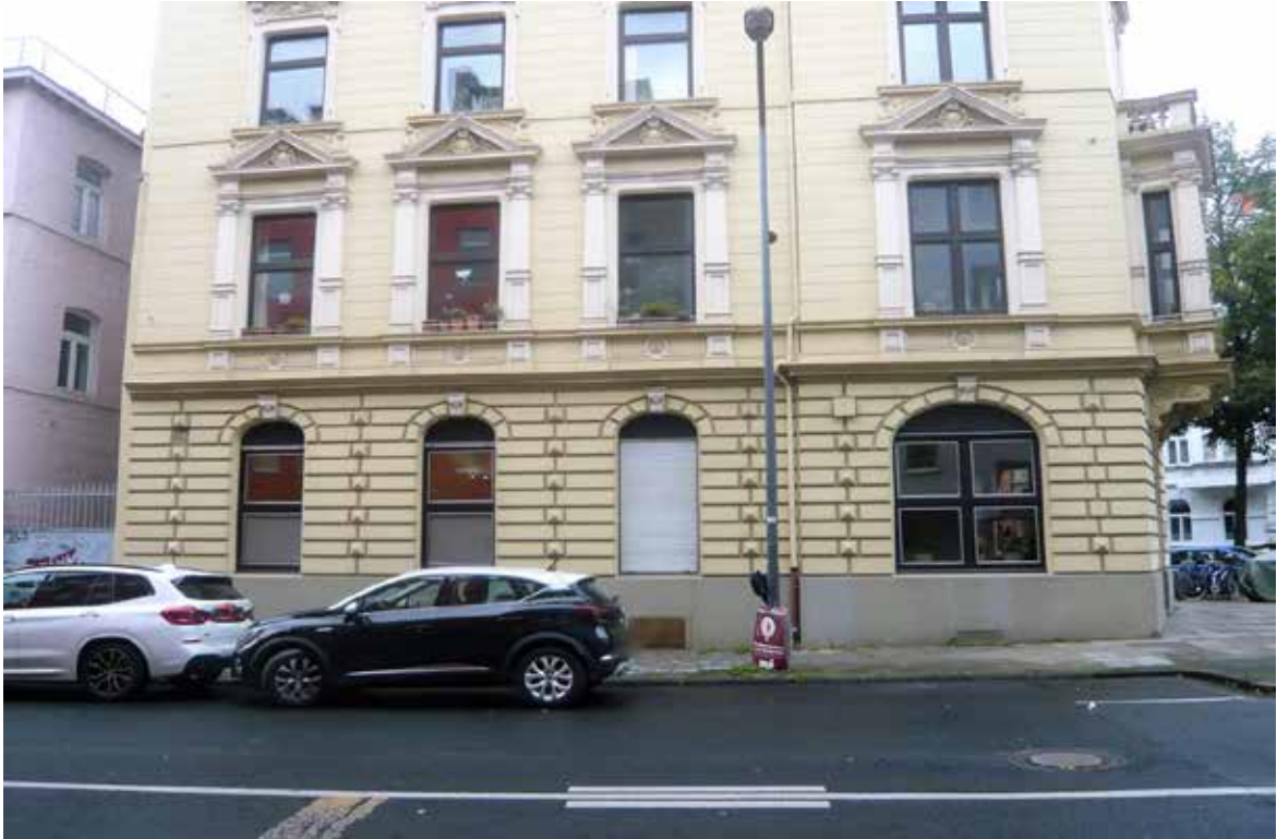
Strassenansicht Bismarckstrasse, ATP Nr. 2 im 1. OG
