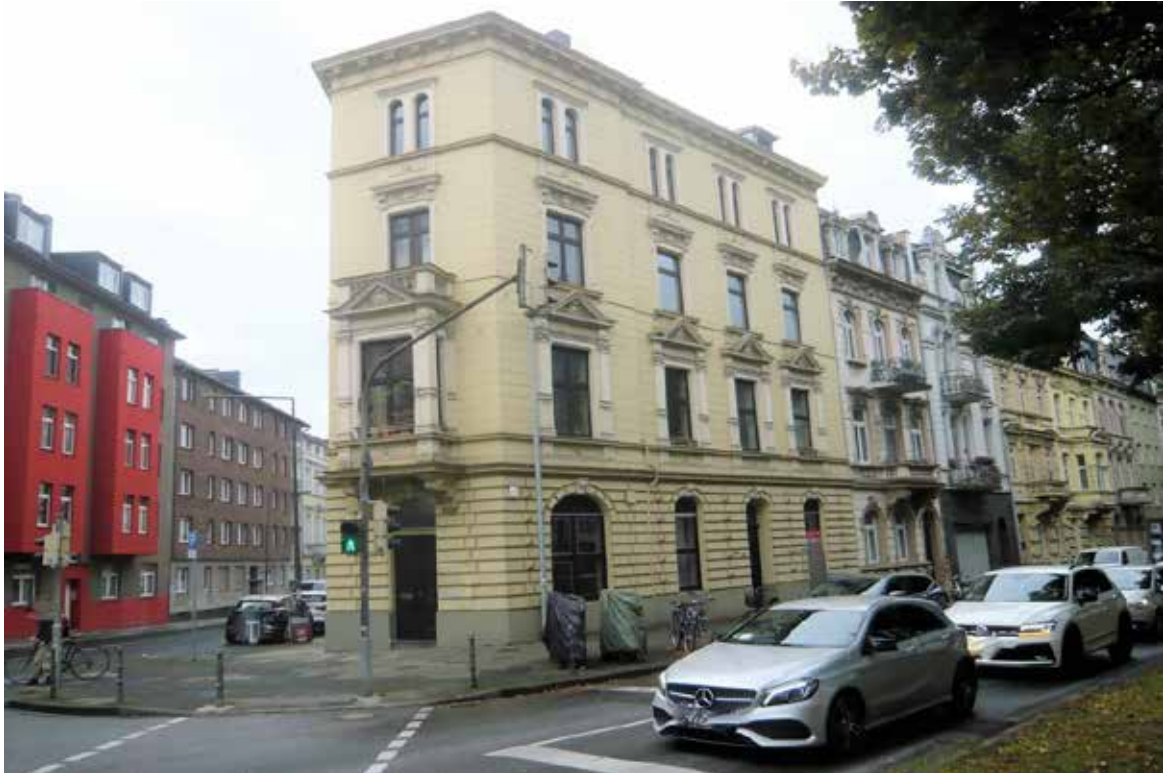
Strassenansicht Oppenhoffallee 138, ATP Nr. 2 im 1. OG links
