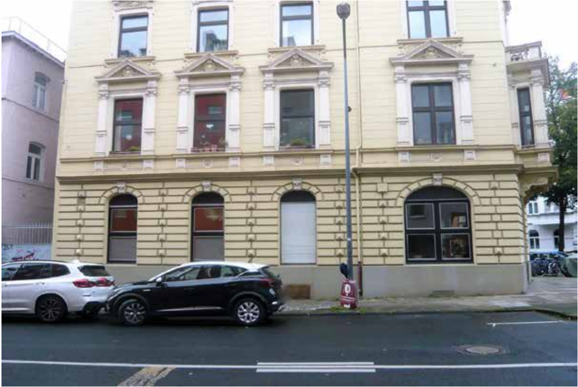
Strassenansicht Bismarckstrasse, ATP Nr. 2 im 1. OG
