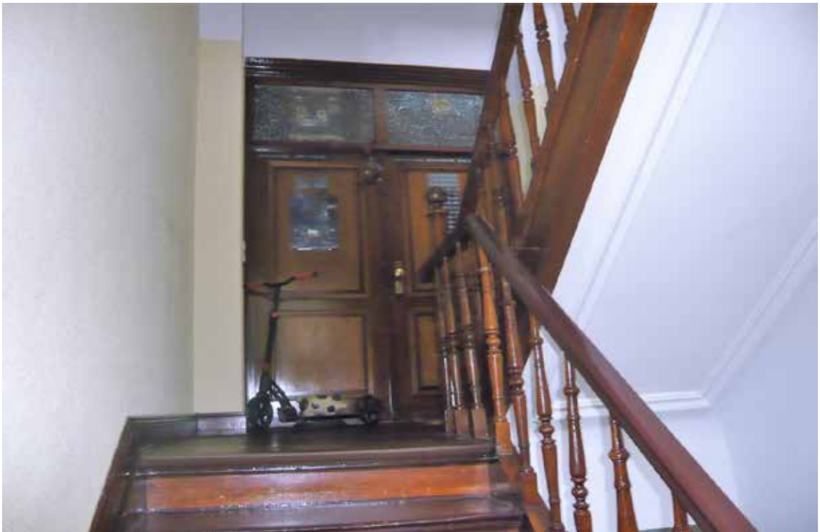
Wohnungseingangstür ATP Nr. 2 im 1. OG links
