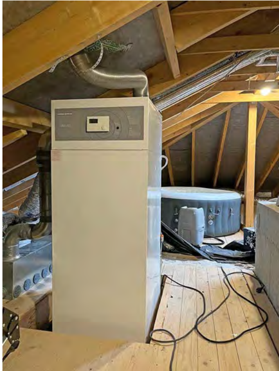
Abluftgerät mit den Funktionen Lüften und Warmwasserbereitung
