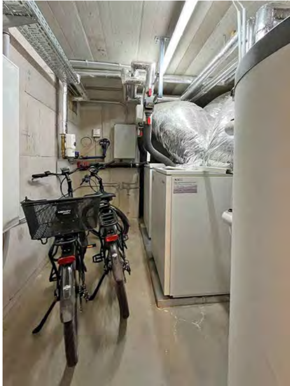
Heizungsraum mit Wärmepumpe
