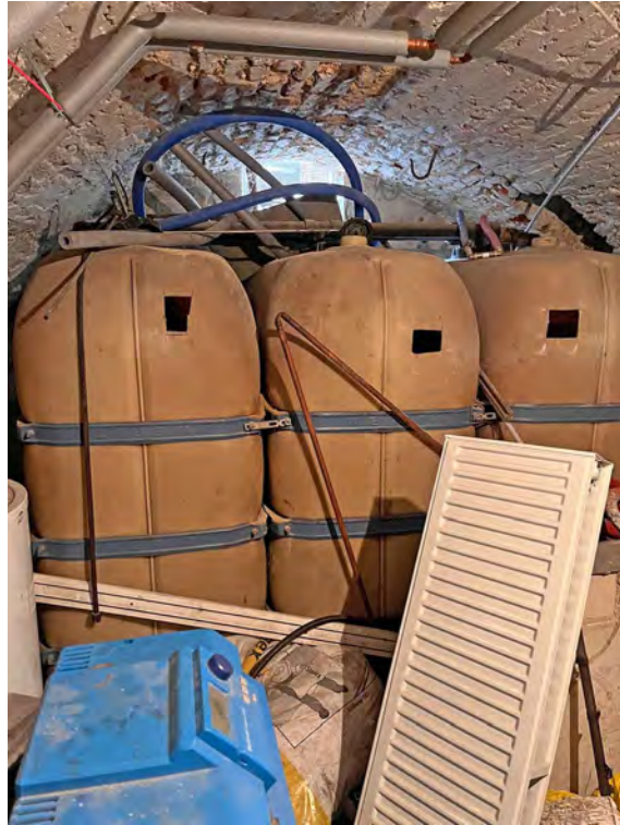
Kunststoff-Öltanks (außer Betrieb)
