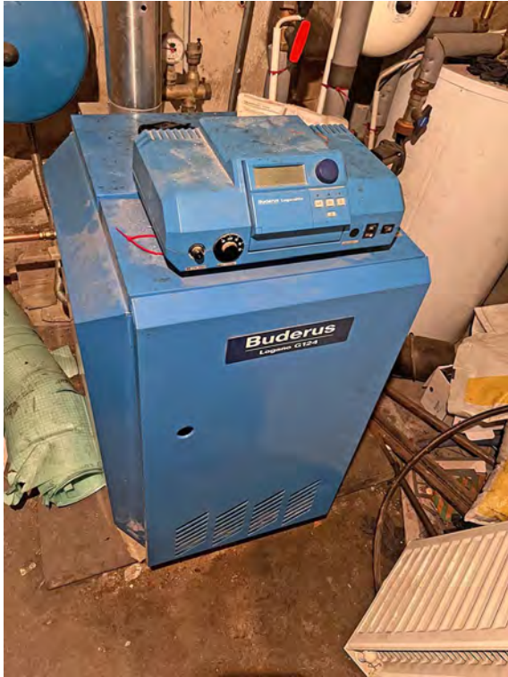
Gaszentralheizung mit Standspeicher
