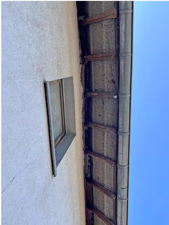
Risse im Fassadenputz und Dachüberstand mit maroder Unterspannbahn
