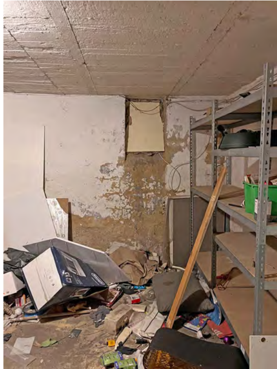
Kellerraum mit Feuchtigkeitsschäden
