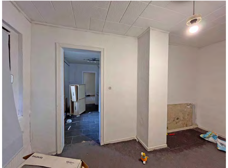
Zimmer hinten in Richtung „Kammer“ mit Feuchtigkeitsschäden
