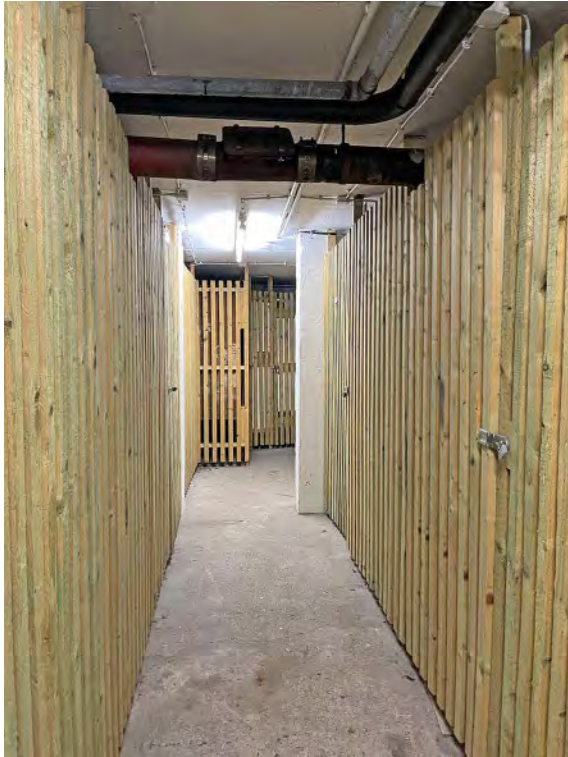
Kellerflur mit Abstellkellern
