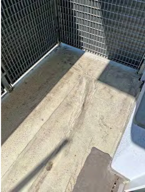
Schadhafter Balkonbelag
