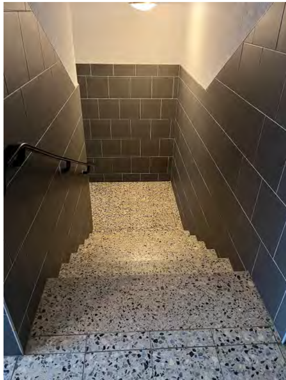
Treppe in den Obergeschossen (exemplarisch)
