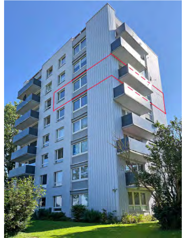
Lessingstraße 21, Ansicht von Südwesten
