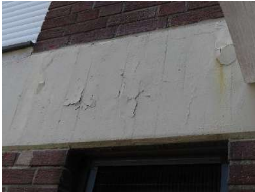
Notwendige Betonsanierung
