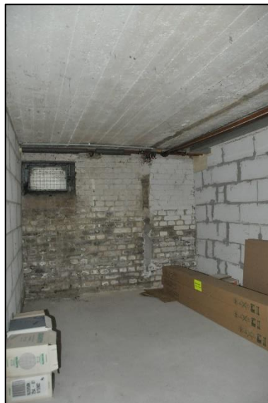
zugehöriger Kellerraum ETW 4
