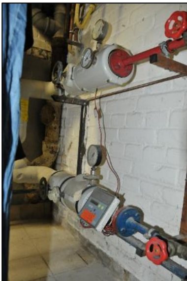
Fernwärmeanschluss
