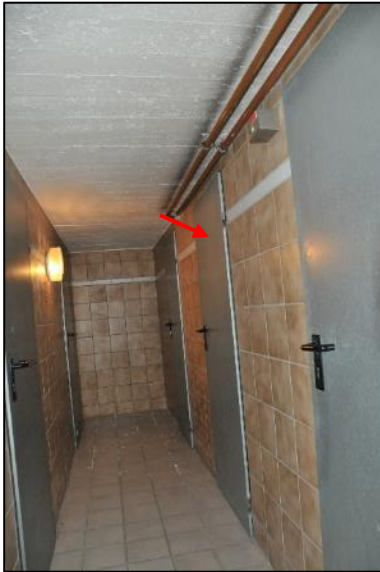
Kellergang, Markierung Keller ETW3
