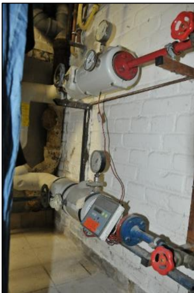
Fernwärmeanschluss
