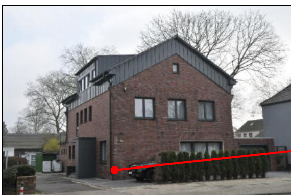
Straßenansicht mit Zufahrt
