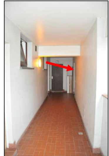
Laubengang, hinten rechts Treppenhaus
