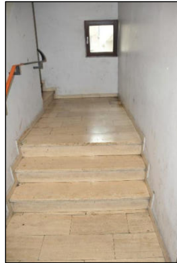
Treppe zum OG
