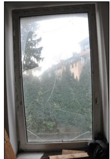
Fenster Treppenhaus Anbau
