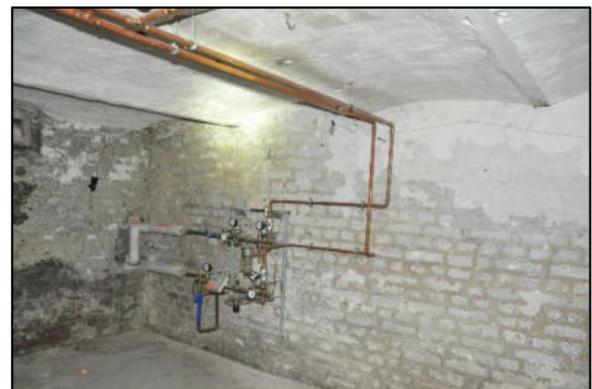
Fernwärmeanschluß
