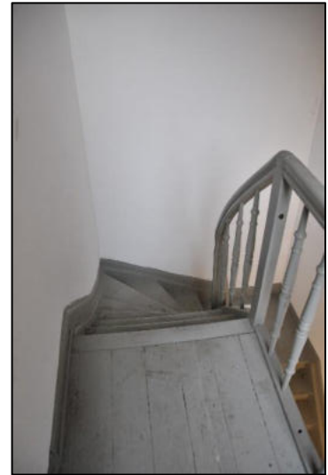
Treppenhaus 1. OG Anbau
