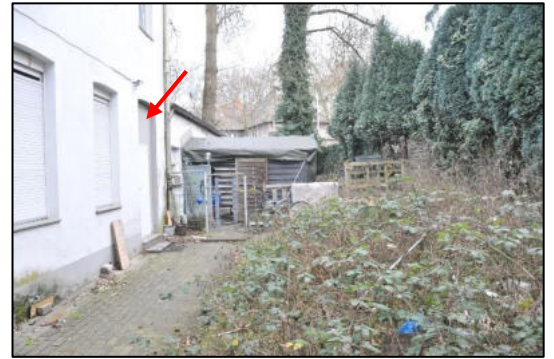
Blickrichtung Anbau, links Zugang
