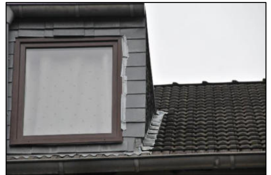
Straßenansicht einer Dachgaube
