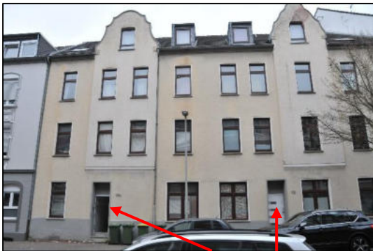
Straßenansicht Uhlandstr. 79a und 79
