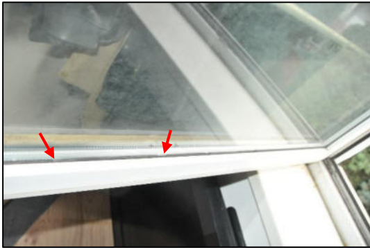
Defekte Dichtung
