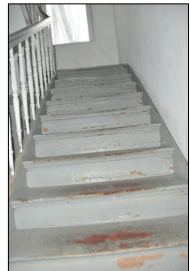
Treppe zum OG HsNr. 79
