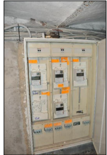
Zählerkasten Strom
