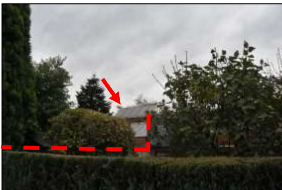
Solaranlage Biggestraße 18, Garten-/Südseite
