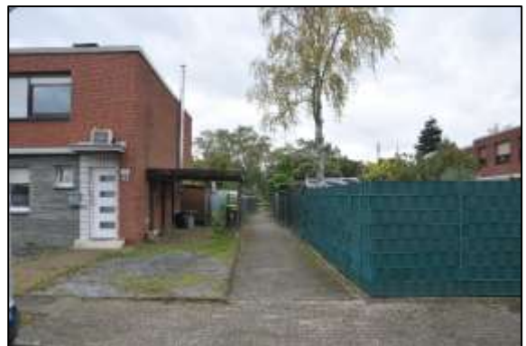
Zugang Garagen, rechts Gärten/Rückseite HsNr. 10-18
