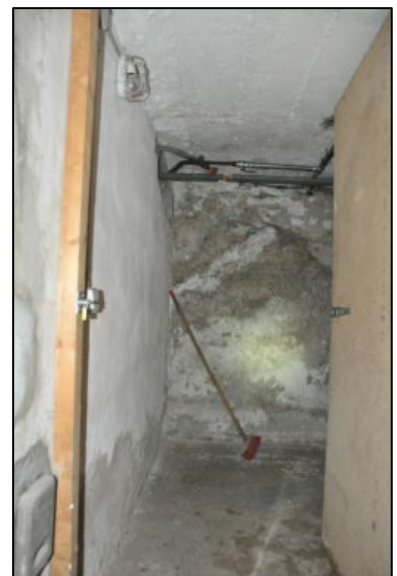
ein zugänglicher Kellerraum
