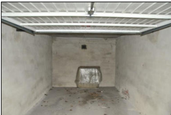
Innenansicht Garage Nr. 12
