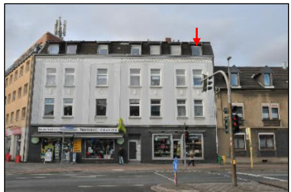
Straßenansicht Beblstraße 171 Markierung = Schlafzimmerfenster ETW 9
