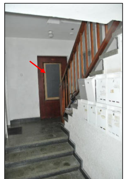
Treppenhaus Erdgeschoss Wohnungstüre Sondereigentum Nr. 17
