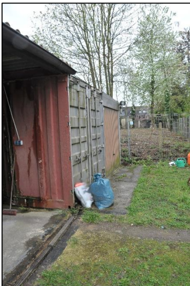
Blickrichtung Süden / Garage
