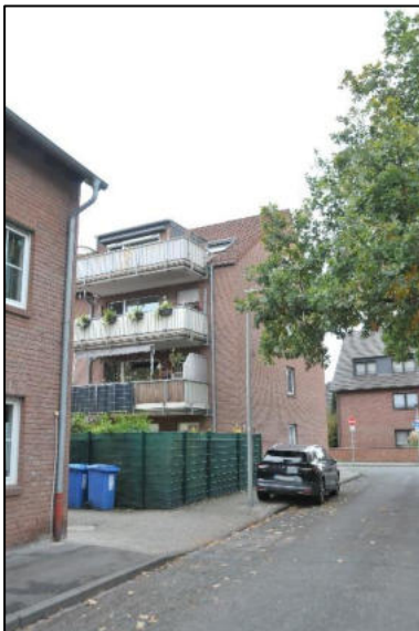
Ostansicht Stubbenbaum 18, links Zufahrt Garagenhof
