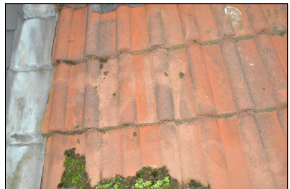
Dacheindeckung im Bereich der Küche
