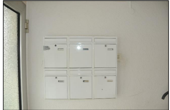
Briefkastenanlage im Treppenhaus
