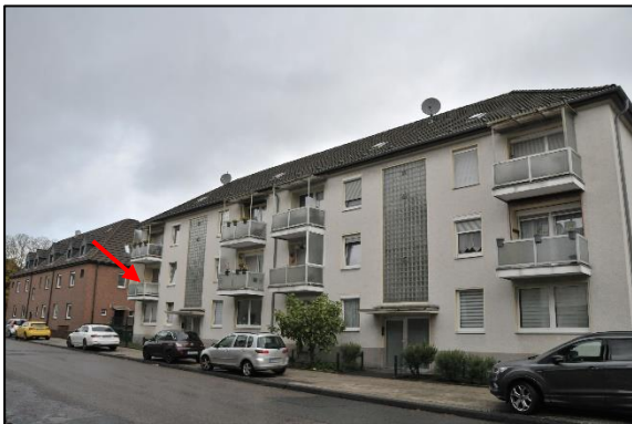
Straßenansicht Alstadener Straße 60/62
