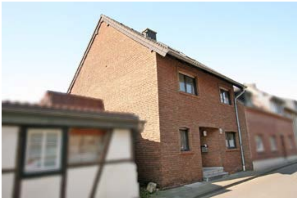
Bild 2: Vorder- und Seitenansicht des Bewertungsjekts aus nordöstlicher Richtung
