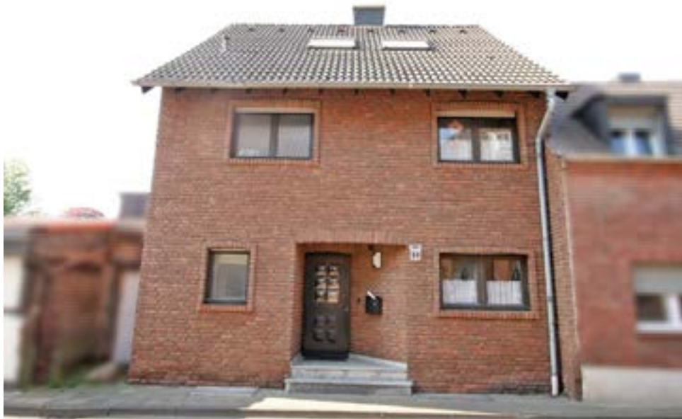
Bild 1: Straßenansicht des Bewertungsjekts aus nördlicher Richtung
