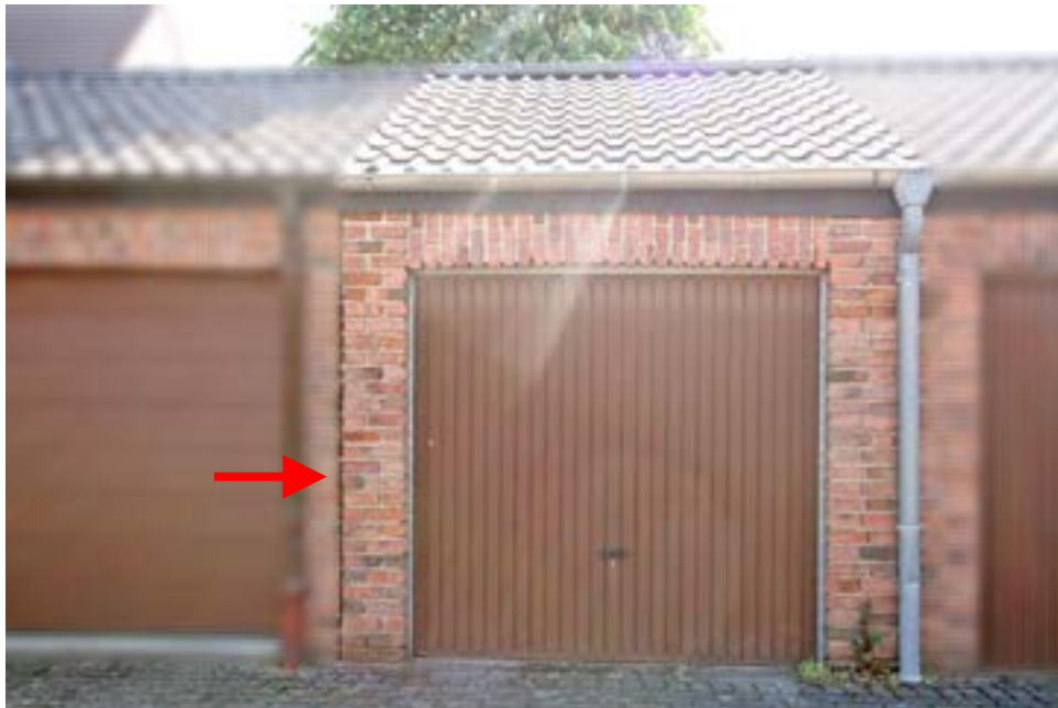
Bild 5: Vorderansicht der Garage des Bewertungsobjekts auf Flurstück 675 aus westlicher Richtung
