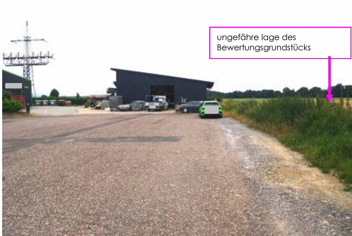
Bild 5: Blick in die Philipp-Reis-Straße in Richtung Südwest
