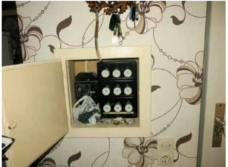
Beispiel Whg. Nr. 3 (Sondereigentum); Elektro-Unterverteilung überaltert
