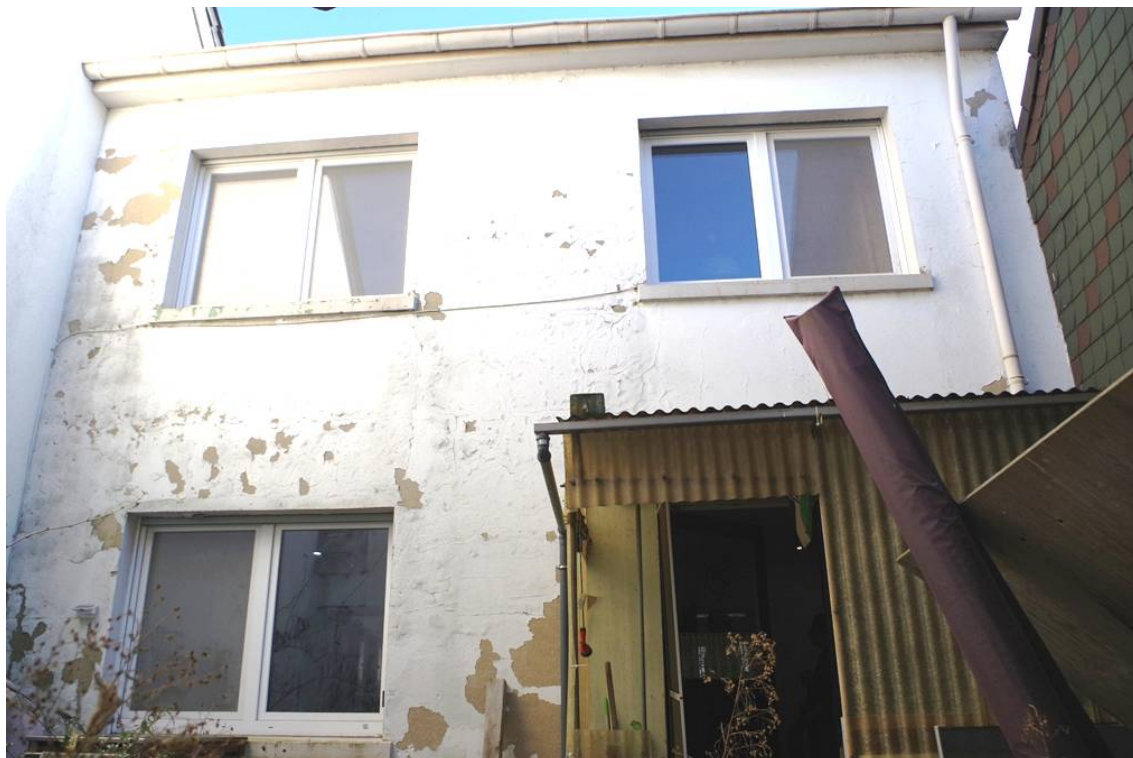
Bild 2: Rückansicht / Hofansicht des Hauptgebäudes aus Nordwest
