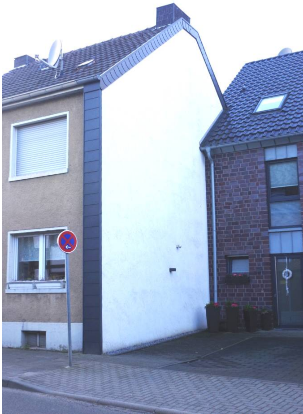
Bild 3: Giebelansicht des Einfamilienhauses aus Südost
