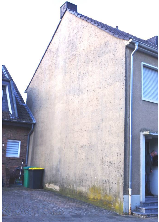
Bild 4: Giebelansicht des Einfamilienhauses aus Südwest
