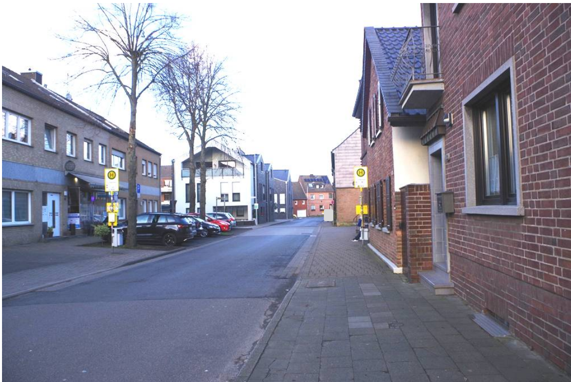
Bild 5: Blick in die Gierather Straße in Richtung Nordost
